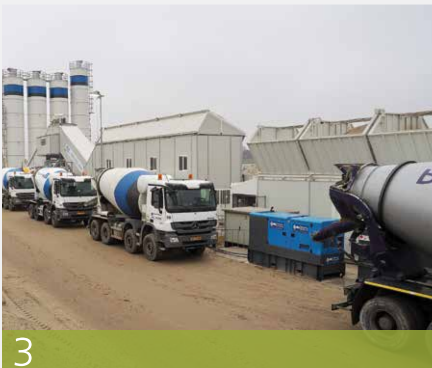
3. LA PRODUZIONE DI CALCESTRUZZO È INIZIATA ALLA FINE DEL 2016 E SI È CONCLUSA NEL 2020 (FOTO: KO VAN LEEUWEN FOTOGRAFIE) / CONCRETE PRODUCTION BEGAN AT THE END OF 2016 AND ENDED IN 2020 (PHOTO: KO VAN LEEUWEN PHOTOS)
