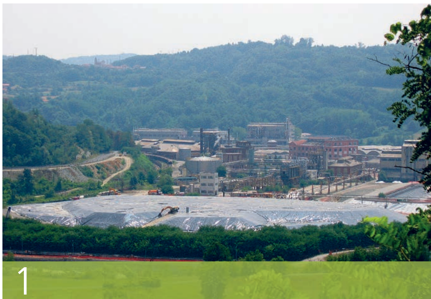
1. ACNA INDUSTRIAL SITE OF CENGIO, SAVONA CANTEIRO INDUSTRIAL DA ACNA EM CENGIO, SAVONA
