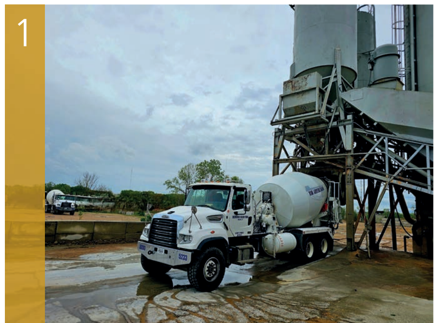
1. READY-MIX CONCRETE TRUCK BEING LOADED AT THE PIDGEON ROOST PLANT. THE WALL TO THE LEFT IS THE WALL TO THE SETTLING PITS CAMINHÃO BETONEIRA PRONTO SENDO CARREGADO NA USINA DE PIDGEON ROOST. A PAREDE À ESQUERDA É A PAREDE DOS POÇOS DE SEDIMENTAÇÃO
